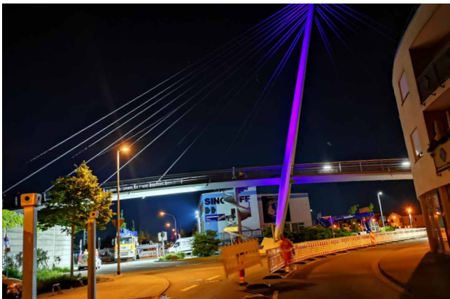
Seilbrücke Cable bridge
