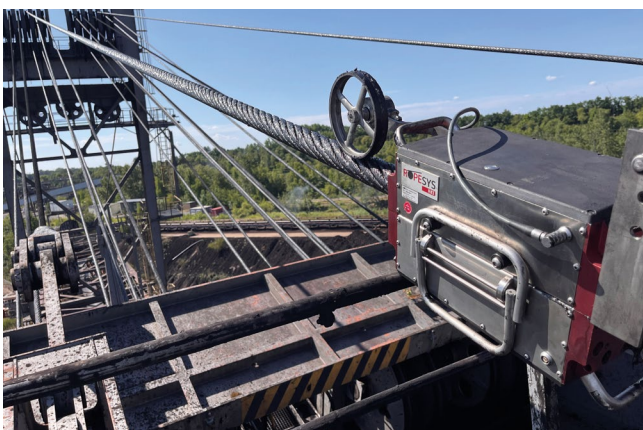
Hubseil-Inspektion Hoist rope inspection
